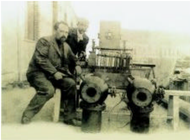
Noter les ballastes sur lesquels le cadres support est fixé. Nous avons là également un ancêtre des robots sous-marins.
